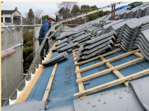
【修理工事の様子】
