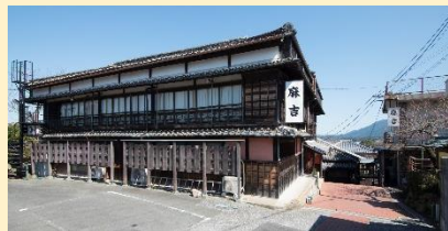
【聚遠楼】西から撮影
